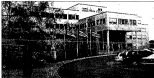
Vor drei Jahren wurde die Atlas Copco-Zentrale an der Langemarkstraße bezogen. Neben der Holding haben vier weitere Tochter-Gesellschaften ihren Sitz in Essen. (NRZ-Foto: Remo Tietz)
